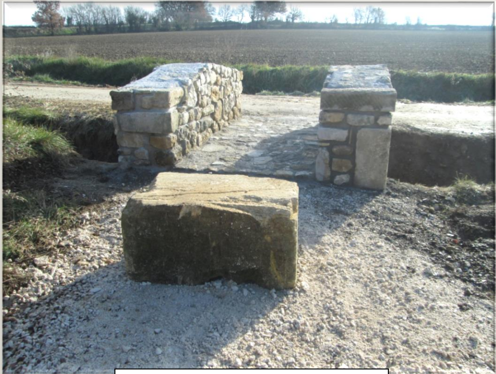
Le pont du chemin de la Maissonette
