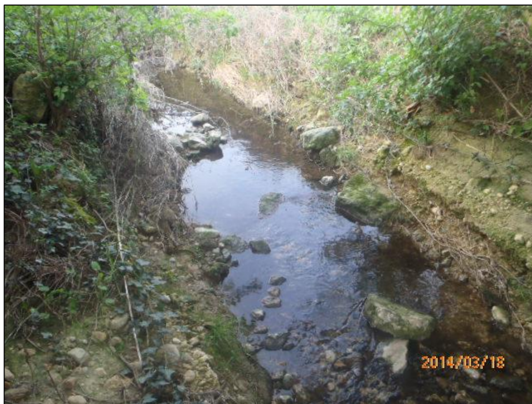
Illustration n°2 : Le ruisseau du Devois au niveau de la station d'épuration de Garrigues
