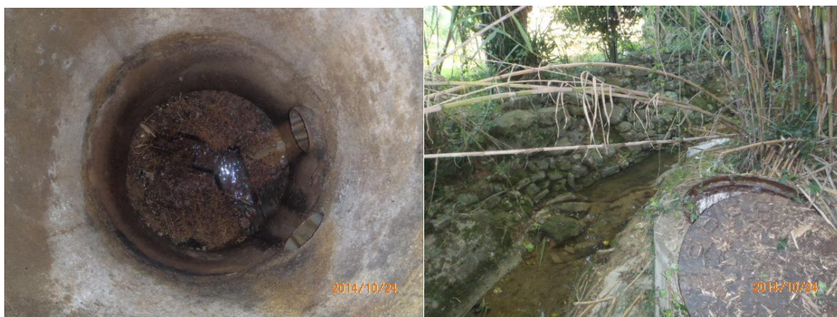
Illustration n°5 : Racines provoquant une gêne à l'écoulement au RV n°141, Sainte Eulalie
