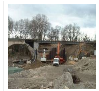
En amont de Ners, réparation du pont de la voie ferrée partiellement emporté (photo BCEOM)
